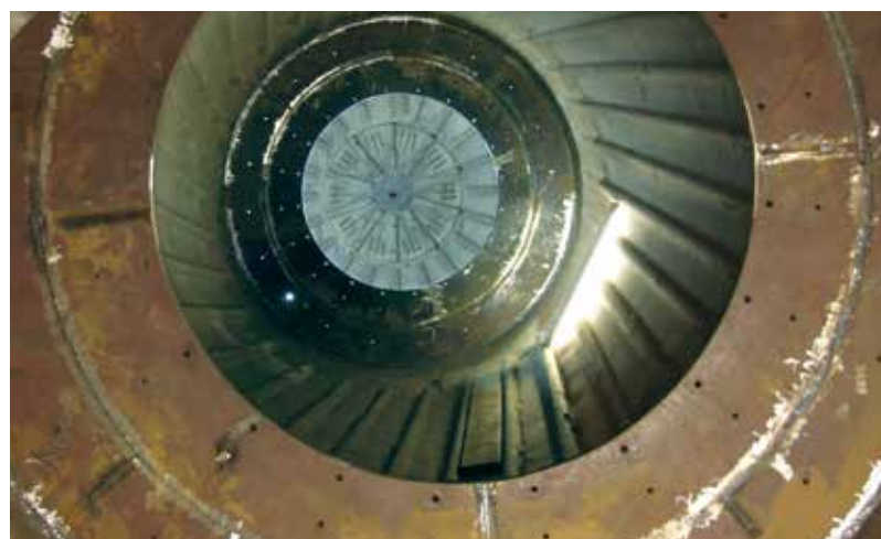
Saldatura accurata dei settori che compongono l'anello.
