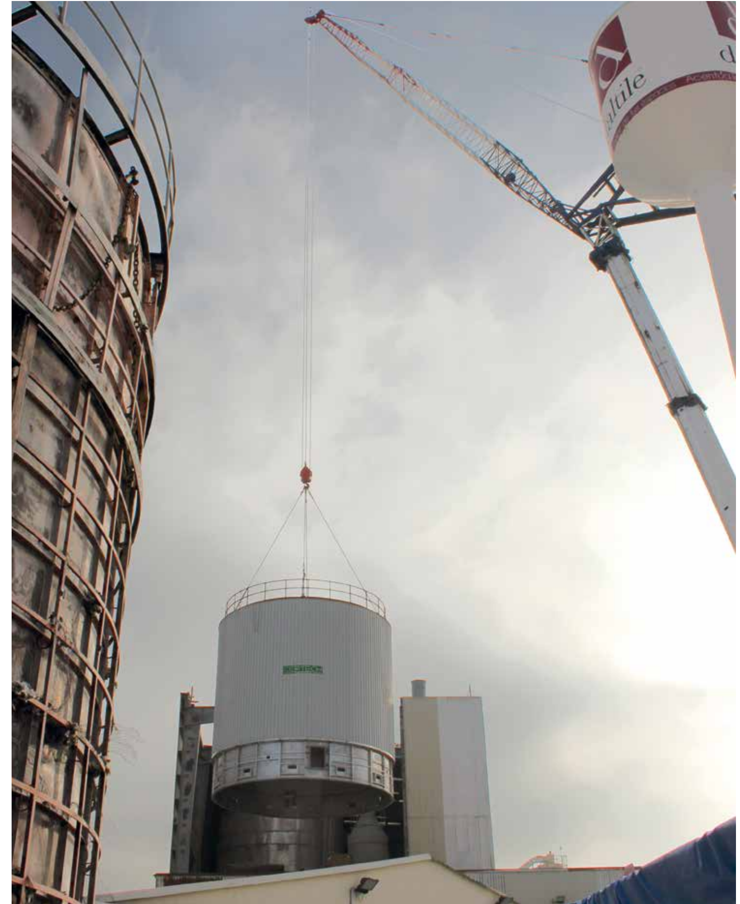
Sostituzione cilindro e cappello con entrata aria calda tangenziale, con uno nuovo di maggiori dimensioni con entrata aria calda centrale. Replacement of cylinder and cap with tangential hot air entry, with a new one with bigger dimensions with central hot air entry. Sustitución cilindro y sombrero con entrada aire caliente tangencial, con uno nuevo de dimensiones mayores con entrada aire caliente central. Remplacement cylindre et chapeau avec entrée air chaud tangentiel, par un nouveau, de dimensions plus grandes avec entrée air chaud centrale.
