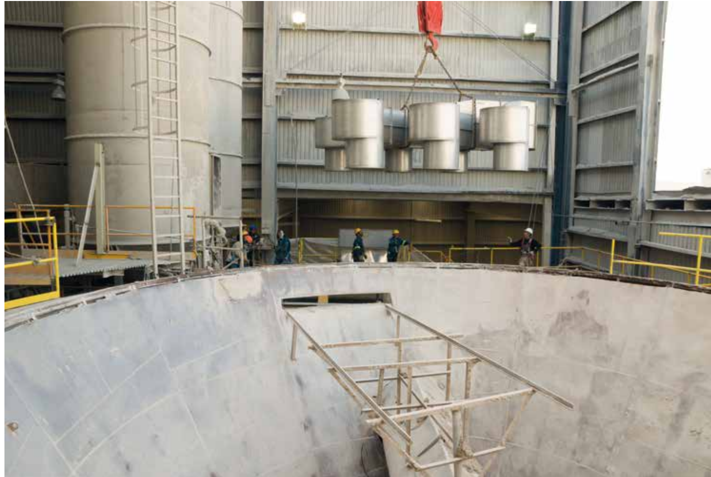
Atomizzatore durante la fase di trasformazione. Spray drier during the transformation phase. Atomizador durante la fase de transformación. Atomiseur pendant la phase de transformation.
