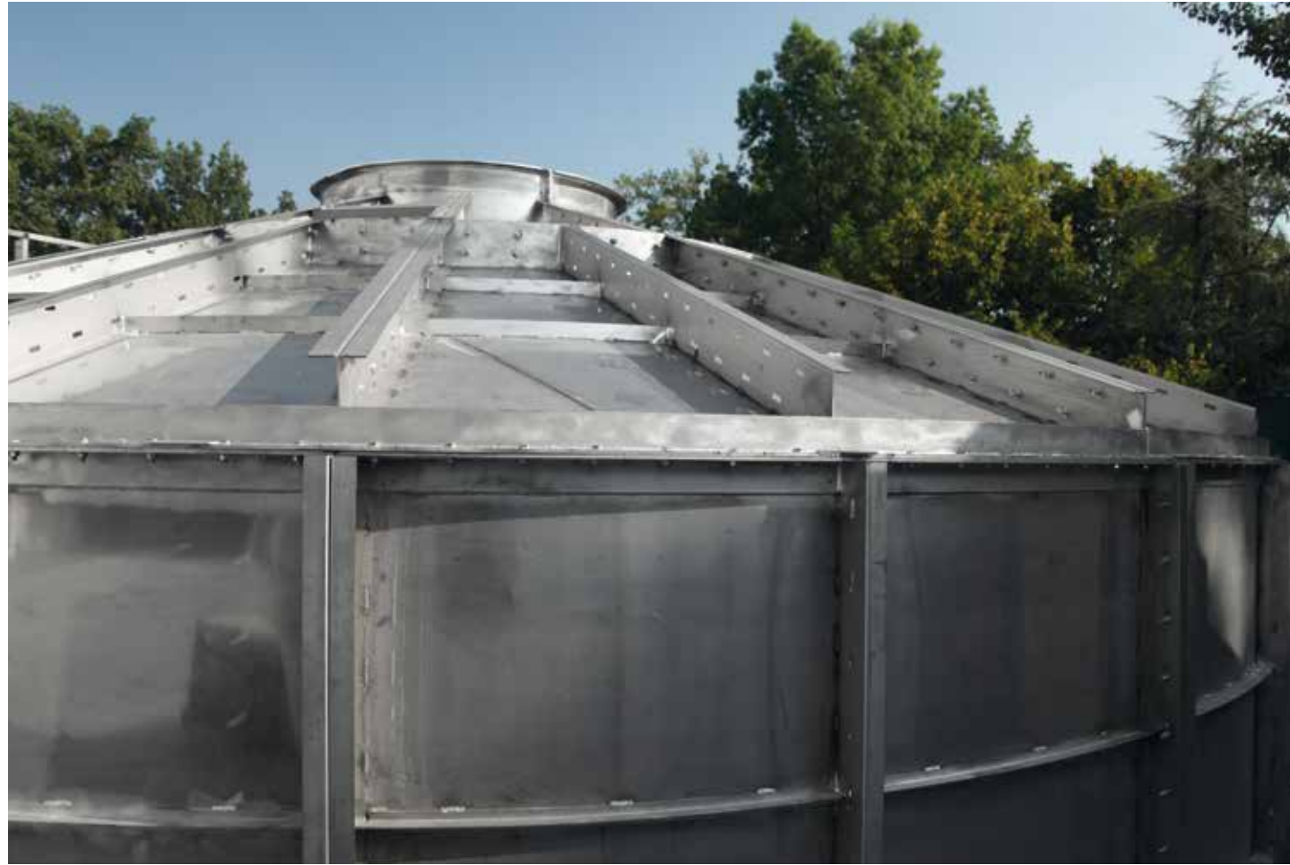
Porzione di cilindro e cappello autoportanti costruiti interamente in acciaio inox. Self-supporting cylinder and cup section completely built in stainless steel. Sección de cilindro y sombrero autoportantes contruidos interamente en acero inoxidable. Section de cylindre et chapeau autoportants construits entièrement en acier inoxydable.
