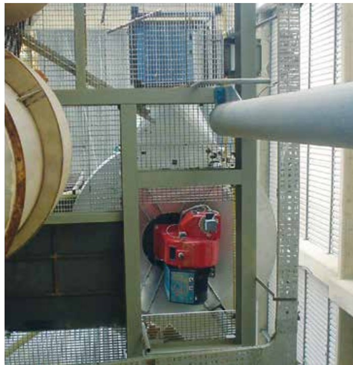
Vista dal basso di camera di combustione, bruciatore ad aria soffiata e ventilatore di pressurizzazione dopo il potenziamento. View from below of the combustion chamber, fanned-circulation burner and pressurization fan after the potentiation. Vista inferior de cámara de combustión, quemador de aire soplado y ventilador de presurización después del potenciamiento. Vue du bas de la chambre de combustion, du brûleur à air soufflé et du ventilateur de pressurisation après augmentation de puissance.
