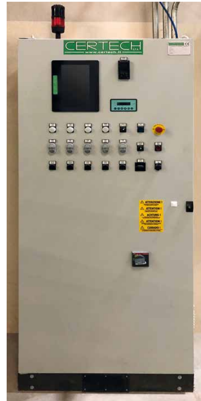
Quadro elettrico con touch screen e PLC. Electric switchboard with touch screen and PLC. Tablero eléctrico con pantalla táctil y PLC. Tableau électrique avec écran tactile et PLC.
