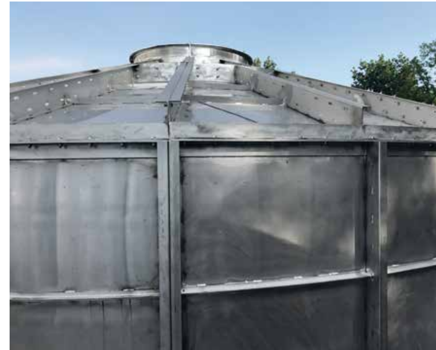
Dettaglio struttura autoportante di cappello e cilindro. Detail of self-supporting structure of cap and cylinder. Detalle estructura autoportante de sombrero y cilindro. Détail structure autoportante de chapeau et cylindre.
