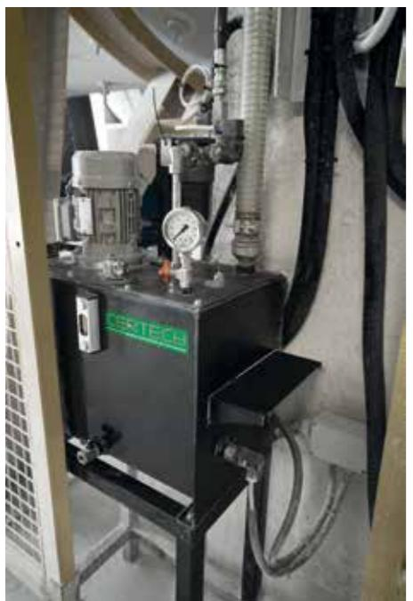
Dettaglio centralina idraulica di lubrificazione cuscinetti.
